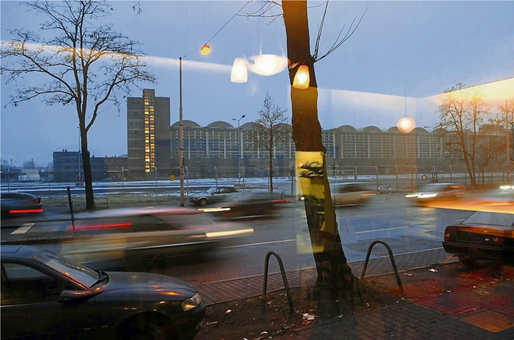
Die Frankfurter Großmarkthalle 2006 vor ihrem Umbau zum Hauptsitz der Europäischen Zentralbank.
